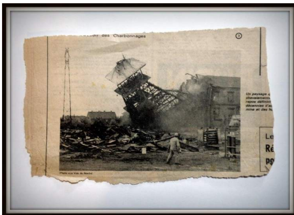
Doc. 7 : une photographie de la période noire ; les mots qui restent sont éloquentes : " un paysage", "chevalement", "repos définitif", "décennies d'ac...", "mine"
